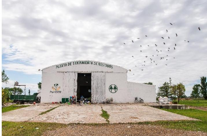
La planta de tratamiento de Residuos de Realicó cuenta con seiscientos metros cuadrados cubiertos, destinados a la separación de los residuos y su posterior tratamiento; con 3 boxes internos para el acopio de papel y cartón y una prensa para estos elementos.
